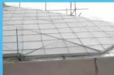
板状保温铺设
