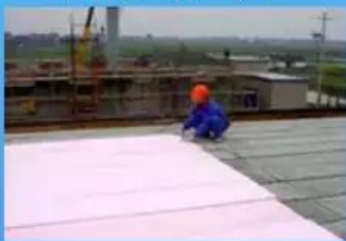
板状保温铺设
