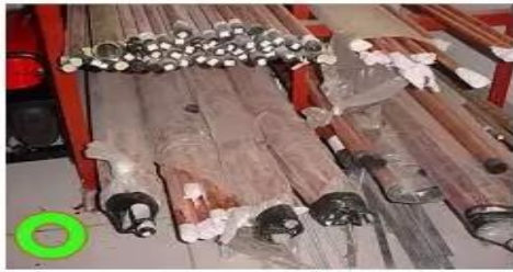
配管离地、封口
