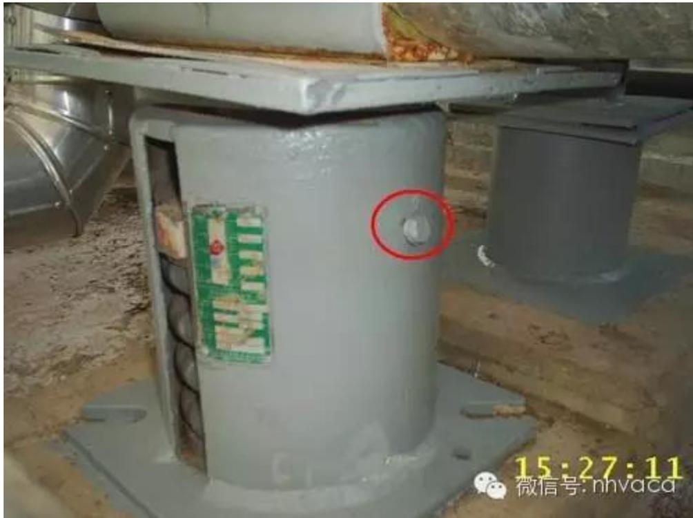
支架下料时必须采用砂轮机切割，严禁采用火焊切割。
