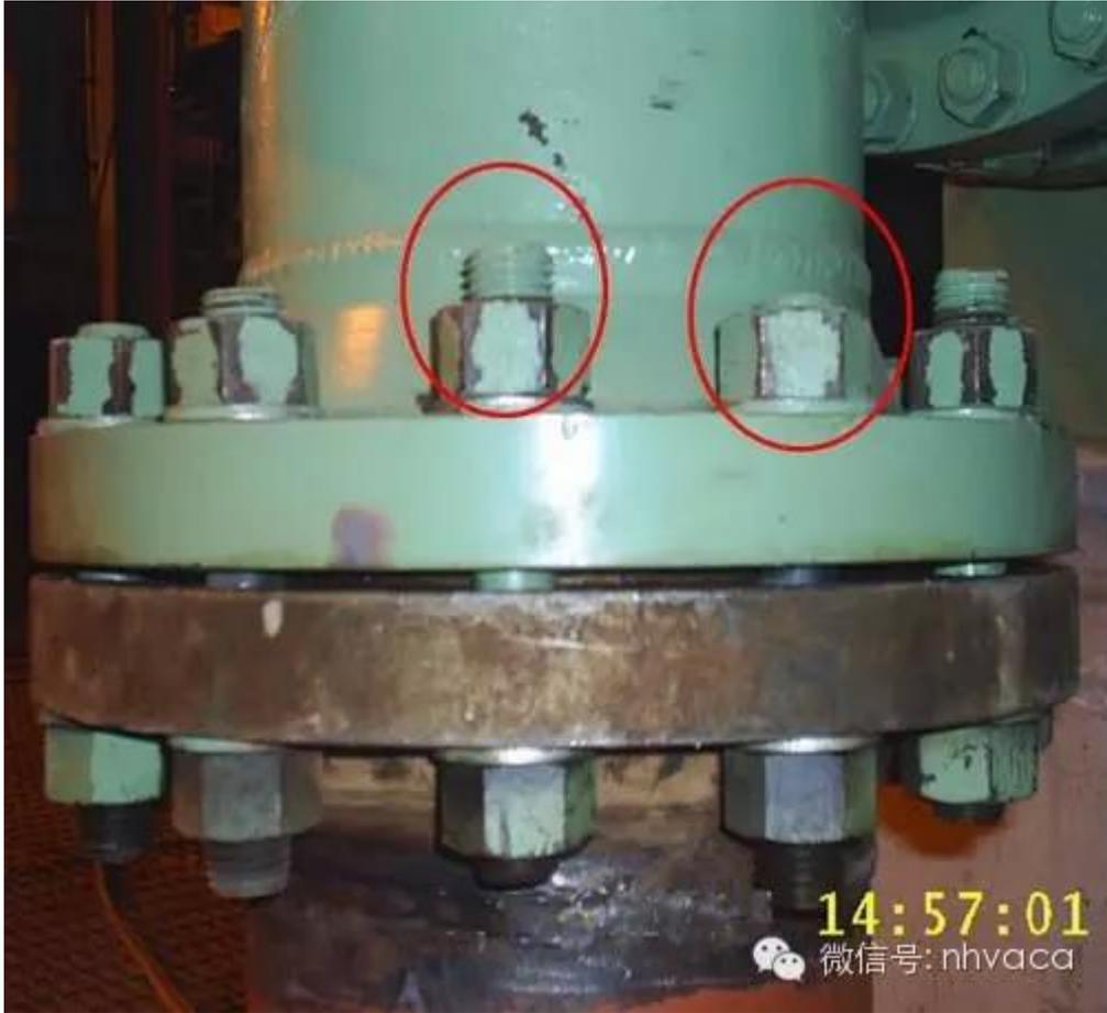
管道支吊架包箍两端外露的螺牙需调至相同。
