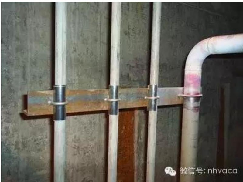
管道安装完成后，对焊缝及焊疤没有在刷油漆前进行打磨平滑，油漆后再进行
