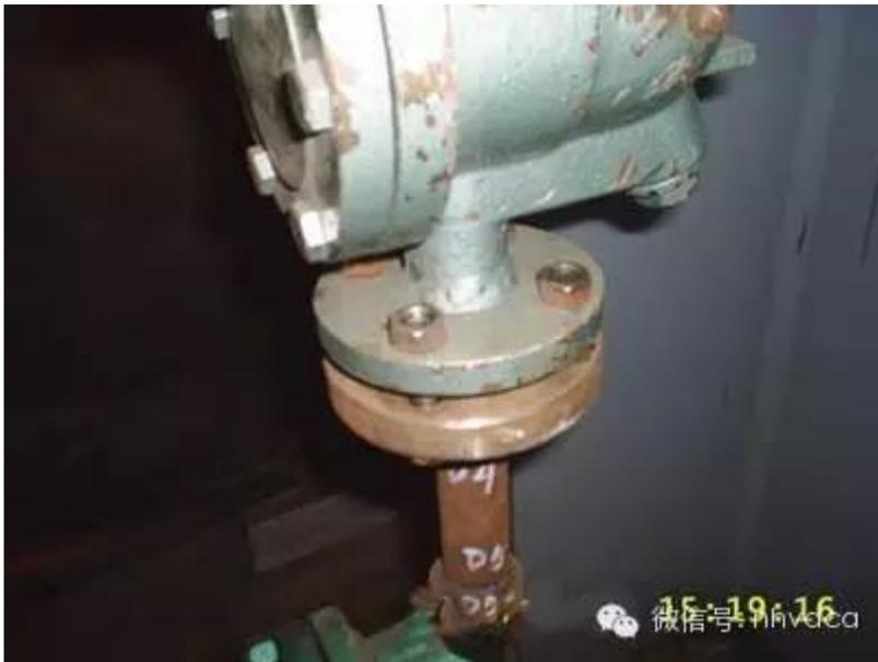
管道同一法兰面采用不同规格的螺栓，不符合要求，需采用同一规格的螺栓。
