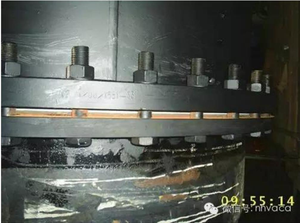
管道法兰螺栓不够长，需更换。（要求：外露 2~3 扣）如果是厂供螺栓需发设备缺陷单要求厂家补供；如果自行购买，技术员须重新做计划购买。
