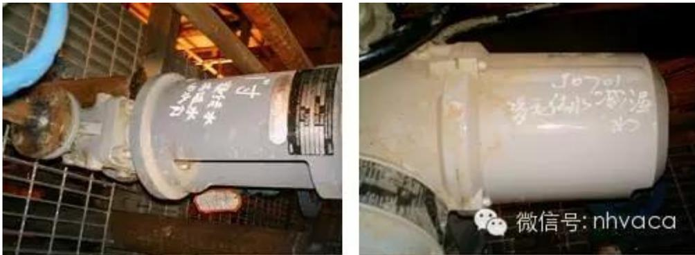
阀门两端口须进行严密封闭，铁屑、沙尘等杂物进入里面没有清理出来，容易造成阀门卡涩及阀门内漏现象。
