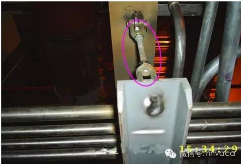
管道法兰连接处螺栓太长，外露 10 牙以上，需切除遗留 2~3 牙。
