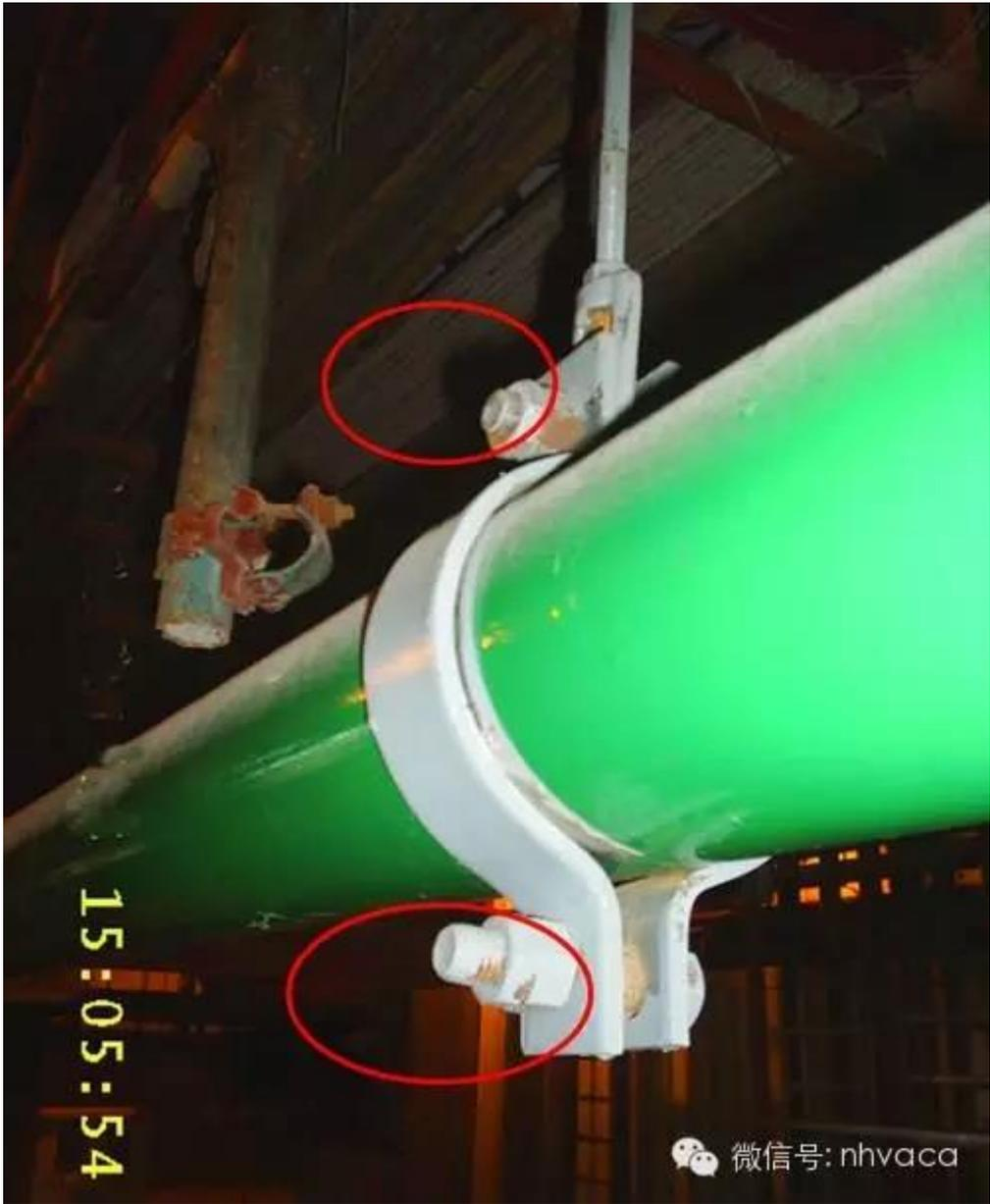
管道支吊架调好后，需将螺栓逼帽锁紧。
