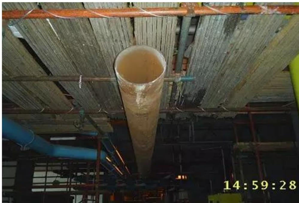
管道暂停安装时，没有按要求进行封堵
