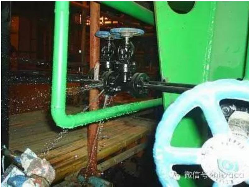
燃机周围管道支架滑动面没有按三菱设计要求，涂二硫化钼等润滑剂，管道运行热膨胀时不能顺利滑动，造成此顶杆歪斜受力不均。
