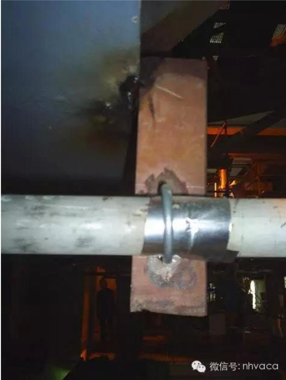
压缩空气管道疏水排污管在#2 机处与辅助蒸汽管道相碰，没有预留保温间隙。
