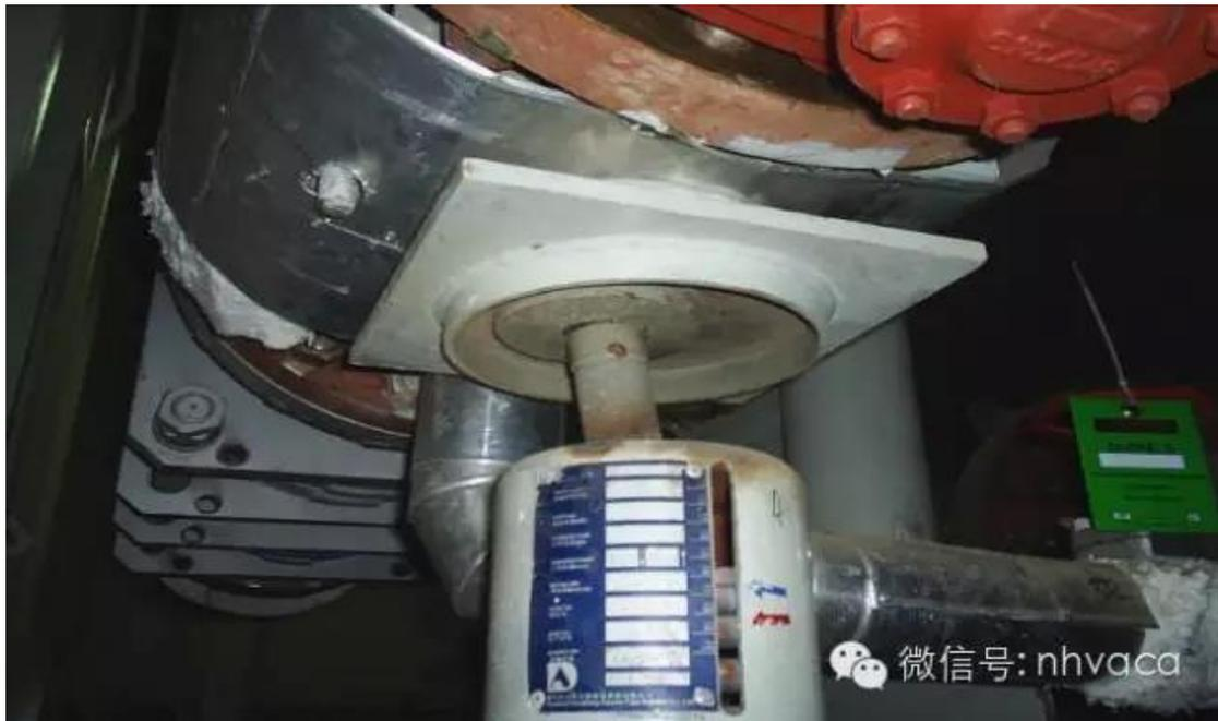
管道吊杆调整不合理，上部外露丝扣太多，而下部却没有上满。（吊杆安装时必须保证丝扣上满，吊杆不够长需更换）
