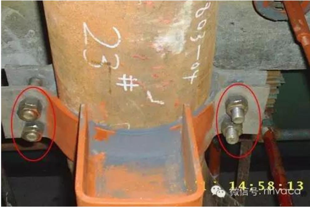
管道吊架包箍上下两头的螺牙需调至相同。
