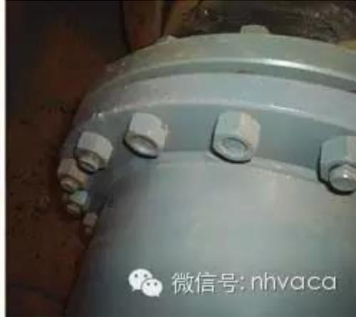
管道法兰及管道支架螺栓防松锁片安装不符合要求，这样安装锁片起不了作用。
