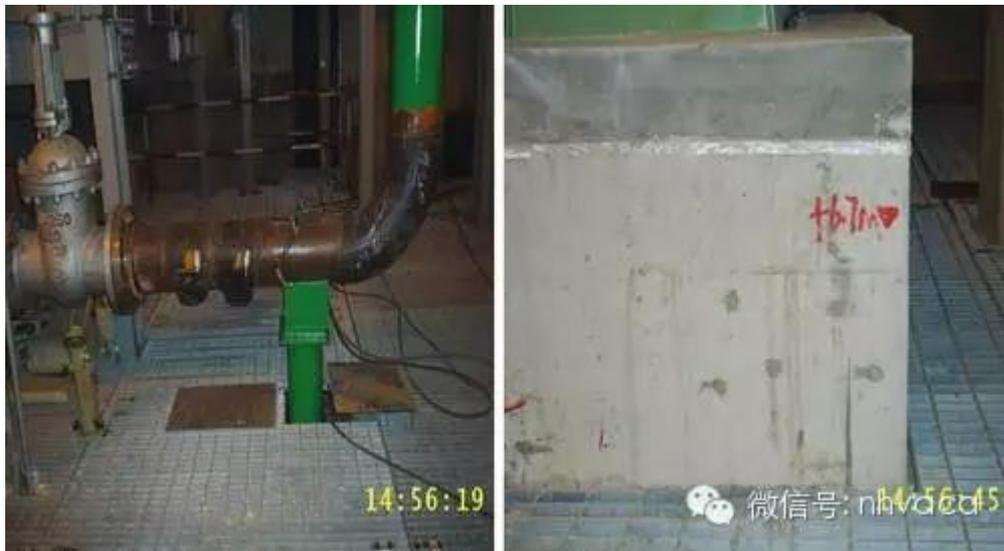
管道支吊架摆放不符合要求, 如此摆放很容易配错, 吊杆容易受外力变形弯曲, 且到后面容易造成缺件。
