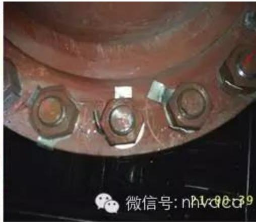
现场较多支吊架都是采用火焊开孔，不符合要求。如图所示支吊架开孔应采用钻孔处理，对于不锈钢管，在包箍管卡处需垫不锈钢垫片。
