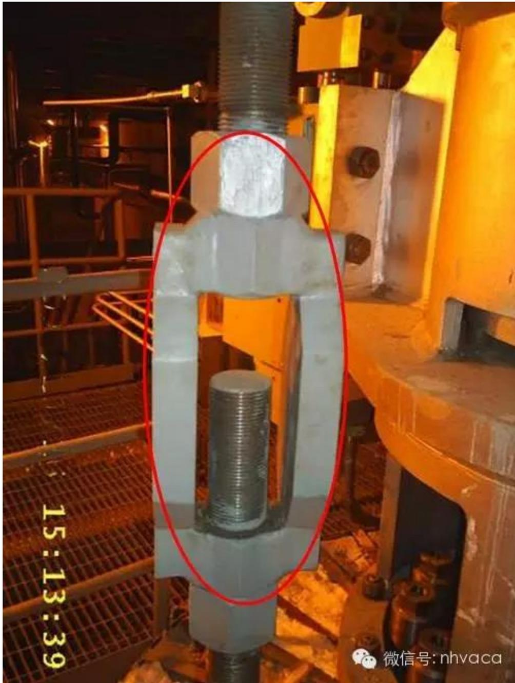
管道支吊架的锁紧螺母漏装。
