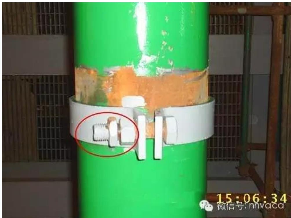
管道支吊架加架吊杆调整时，需将此处的螺牙调均匀。
