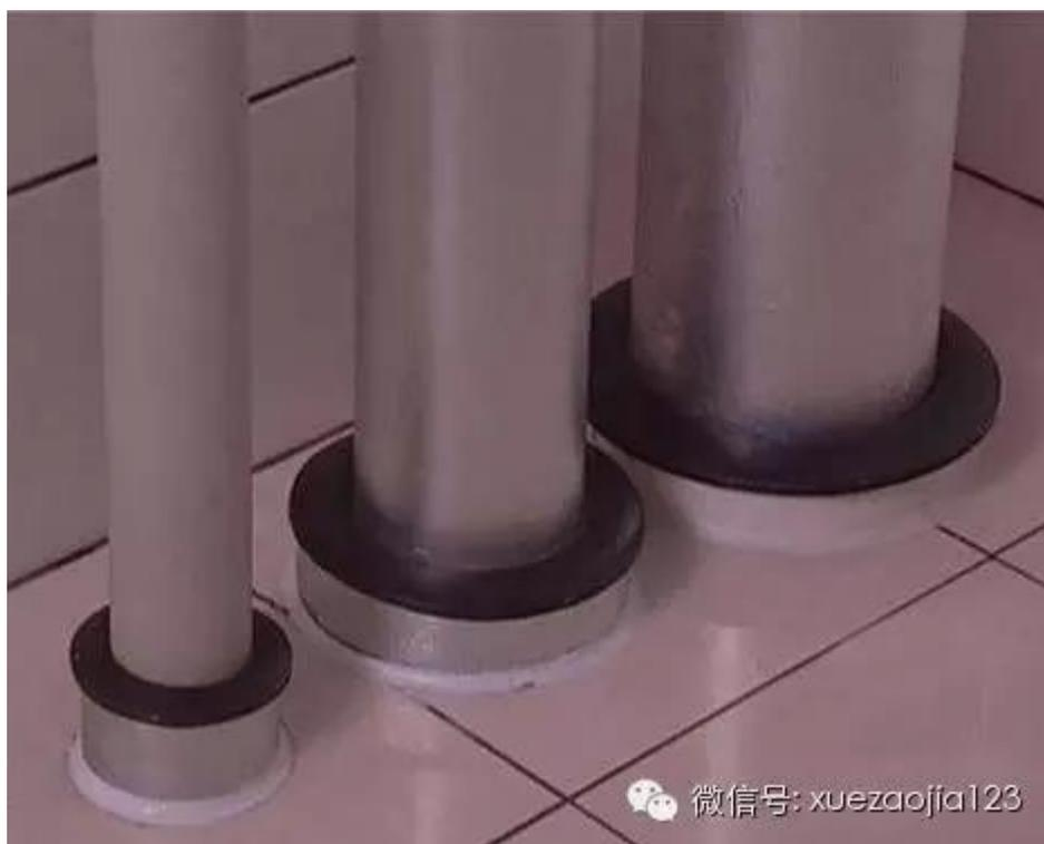
**特色：成排套管露出装饰地面高度一致，管道与套管中心线一致，套管表面做防水油膏**
