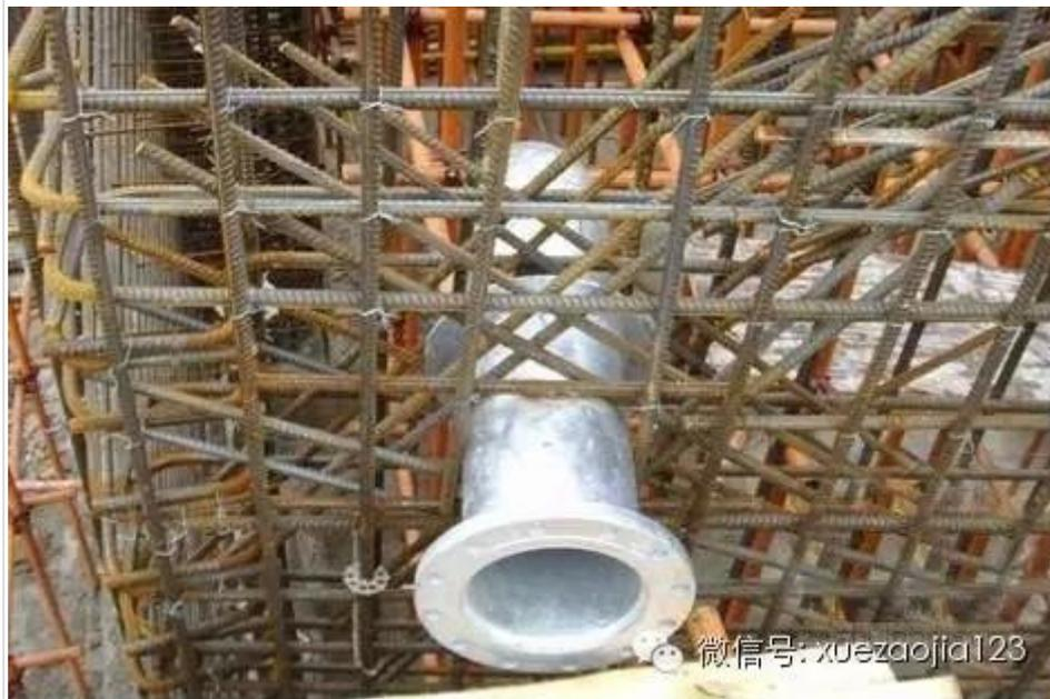
特色：管道穿墙处均采用钢筋进行加固处理
