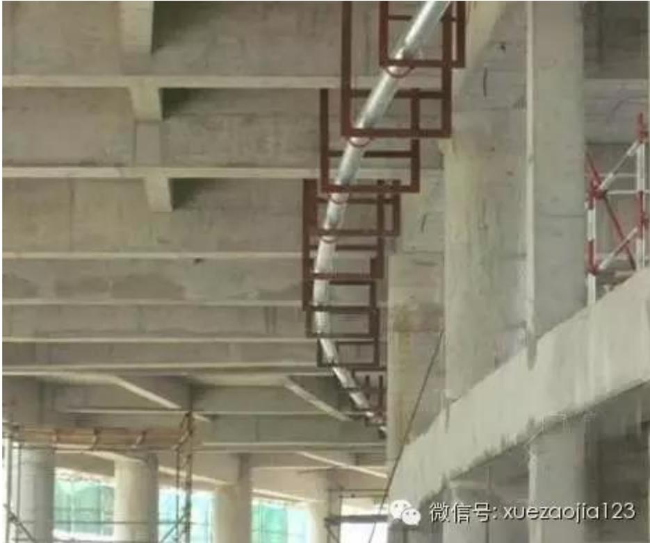
**特色：按实际梁弧度下料，并采用挠性卡箍连接，保证管道与梁的弧度一致**
