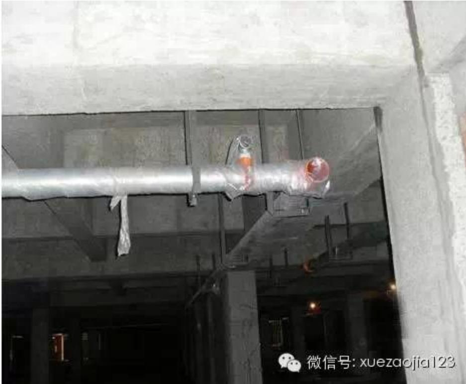
特色：地下室抹灰前，对管道半成品包塑料薄膜进行保护
