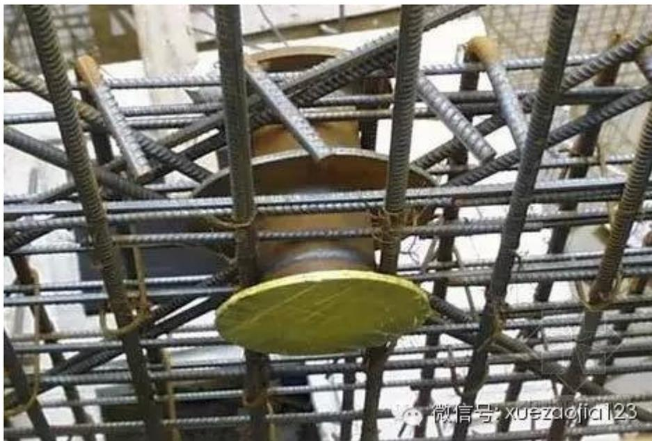
**特色：套管固定采用附加筋固定，附加筋绑扎在结构主筋上；套管固定牢固，位置正确；法兰保护到位**
