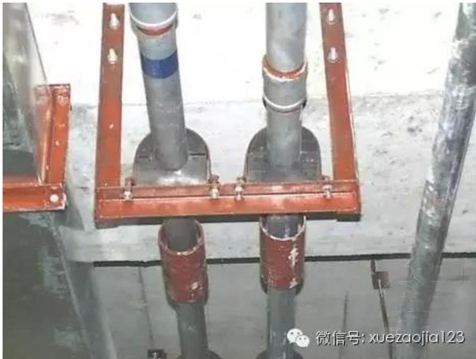
特点：木托与管道接触严密，木托外径与保温层相平齐；吊杆垂直并在一个平面上，木托与管道相匹配，套管预留规范、到位
