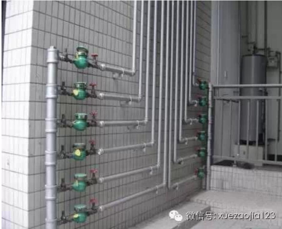
**特色：**水表安装在一层采光井内，给水支管顺着外墙垂直敷设。水表、表前阀、表后阀安装位置竖直一条线，管道支架成“八”字形安装，给水支管间间距均匀
